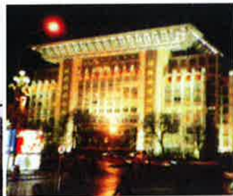
国家电力调度中心 Beijing, China
